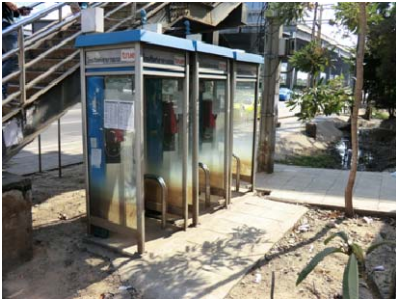
Bang Khen station 付近での洪水の痕跡
