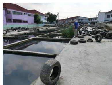
Bang Yai の住宅地にある酸化池
