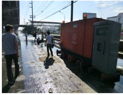
Don Mueang 空港付近でのポンプによる排水
